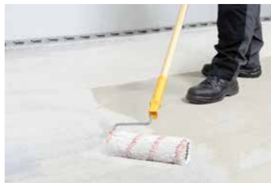
Die gebrauchsfertige 1-K-Grundierung eignet sich optimal für die Verlegung großformatiger Fliesen, insbesondere auf feuchtigkeitsempfindlichen Untergründen. Foto: Saint-Gobain Weber
